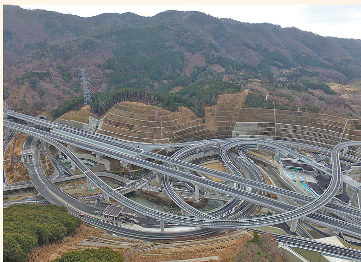
新名神高速道路 箕面とどろみ IC 写真提供 ▶ 「大阪府道路公社」
