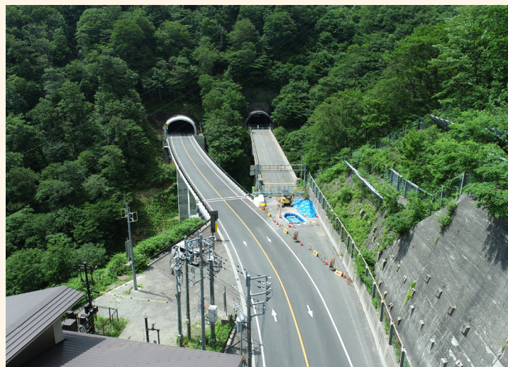
国道 17 号 新三国トンネル (2022 年 3 月 19 日 開通)
