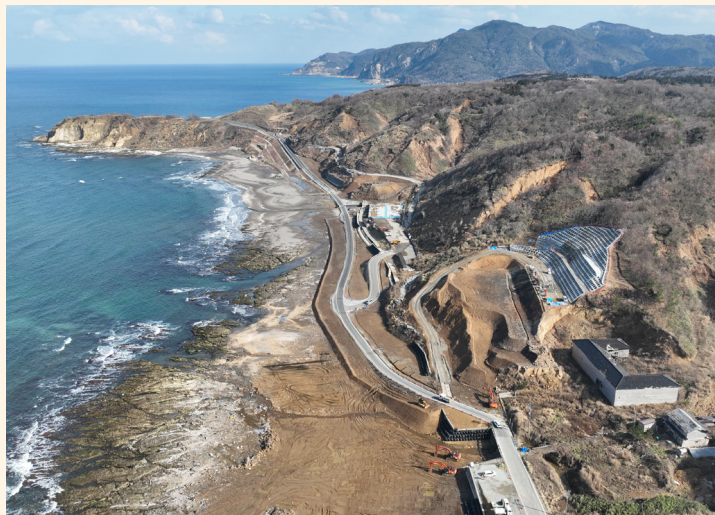
国道 249 号 大川浜工区/三ツ子浜付近 (輪島市浜田町)
